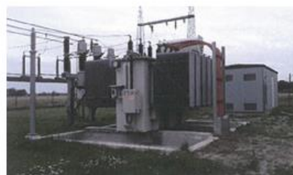
Eksempel på udformning af transformerstation (60/10 kV)
