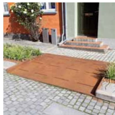
Klimasikring mod de meget større regnmængder vil bl.a. indebære, at regnvand bør afledes på overfladen. Fotos er fra inspirationstur til Middelfart i 2020.
