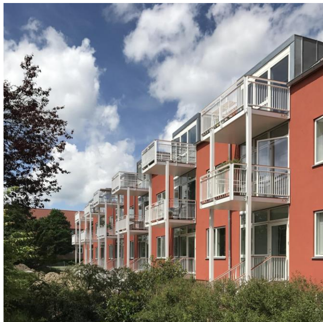
(Energi)reovering Toftebo, Bjerg Arkitektur
