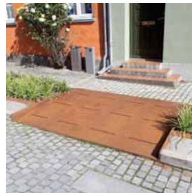
Klimasikring mod de meget større regnmængder vil bl.a. indebære, at regnvand bør afledes på overfladen. Fotos er fra inspirationstur til Middelfart i 2020.
