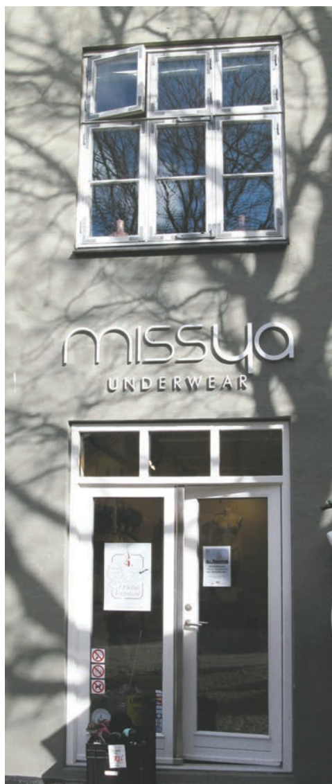
Facadeskilt opsat med enkeltbogstaver tilpasset dørbredde.
