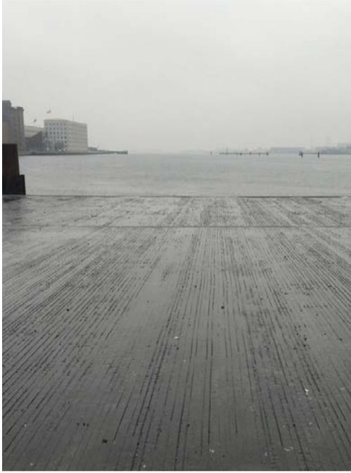
Kvæsthusmolen, København. Råhed - revet beton overflade, skridsikre, rolig og homogen belægning.
