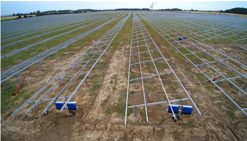
Aluminiumsstativer påsat invertere (blå)
